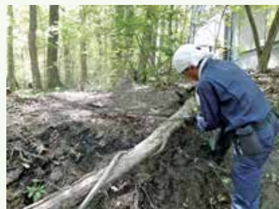
倒木処理 作業中 (バケーションランド別荘地)
