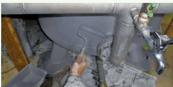
水道施設内タンク塗装 作業中 (グレートハイランド別荘地)
