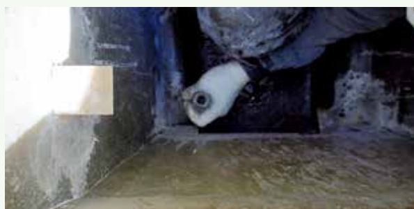
浄化槽内部 亀裂修繕工事 作業中
