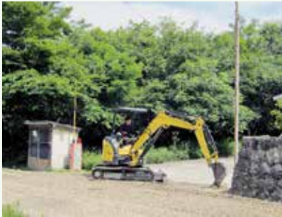
道路補修工事 作業中 (景勝苑別荘地)
