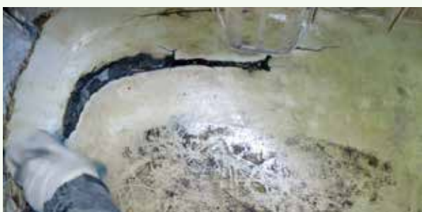
浄化槽内部 亀裂修繕工事 作業中
