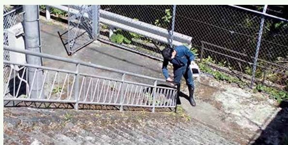
水道施設の手摺塗装 作業中 (レークサイド別荘地)
