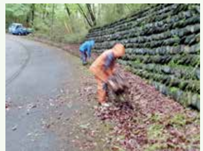
側溝清掃 作業中 (吉野台別荘地)
