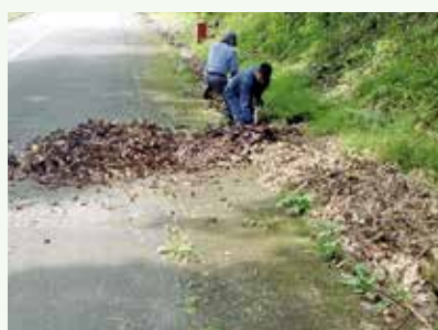
側溝清掃 作業中 (バケーションランド別荘地)
