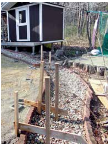
フェンス柱土台設置工事 作業中
