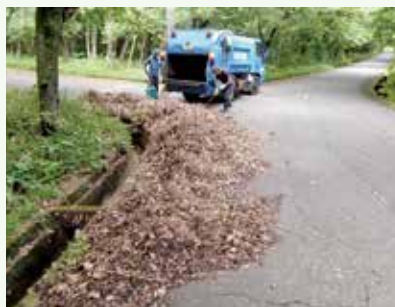
側溝清掃 作業中 (桜台別荘地)
