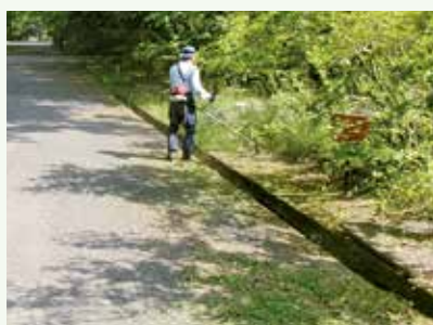
道路路肩の草刈り 作業中 (上の原高原別荘地)
