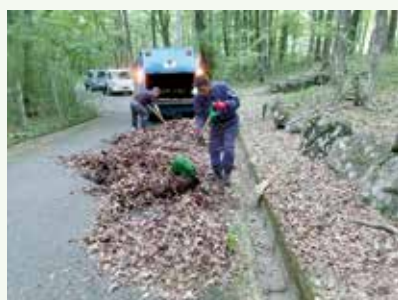
側溝清掃 作業中 (上の原高原別荘地)
