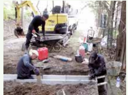
側溝補修工事 作業中 (グレートハイランド別荘地)
