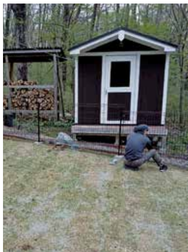
フェンス下網張工事 作業中
