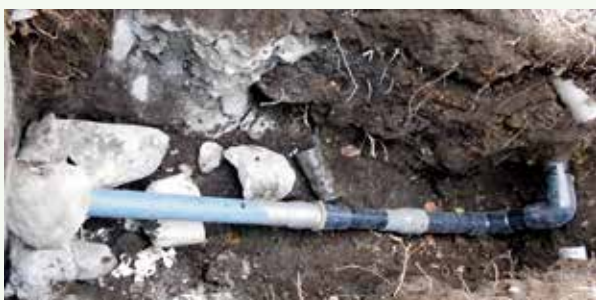
浸透井戸配管敷設替え工事 作業中 (那珂川8期別荘地)
