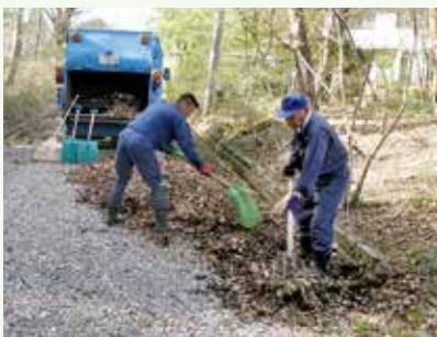
側溝清掃 作業中 (那珂川別荘地)
