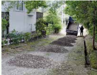
道路補修工事 作業中 (グレートハイランド別荘地)
