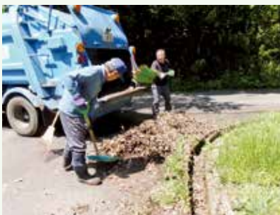
側溝清掃 作業中 (レークサイド別荘地)
