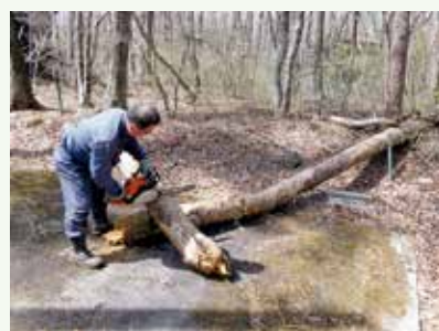
倒木処理 作業中 (上の原高原別荘地)
